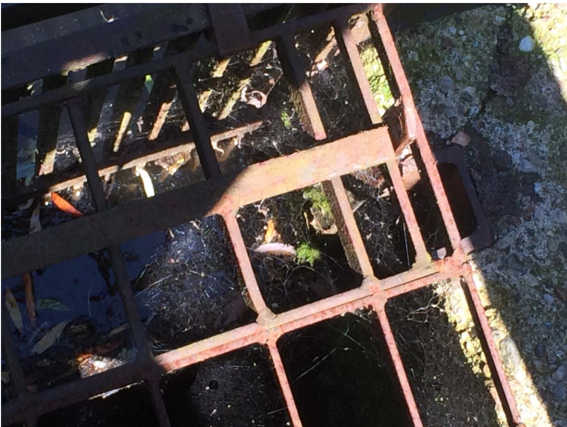
Zniszczenia i spękania betonowego muru oporowego.
