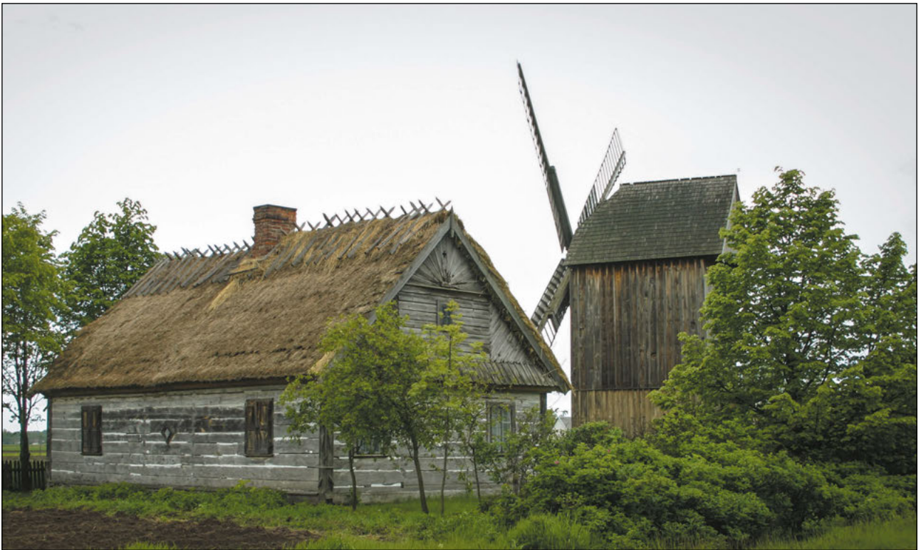
Fot. 4. Zagroda młynarza w Drewnowie Ziemakach, fot. Ł. Uszyński.
