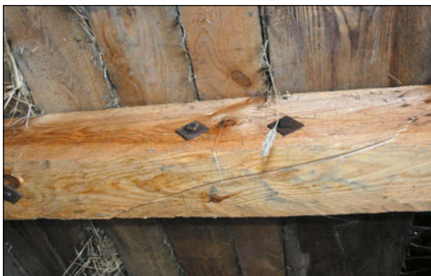
Fot. 1. Wzmocnienie belki stropowej – zagroda drewniana ze wsi Niemce.
