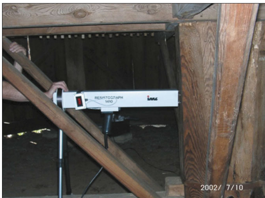
Fot. 5. Badanie konstrukcji zabytkowego kieratu na terenie Muzeum Rolnictwa w Ciechanowcu, (fot. K. Krajewski).
